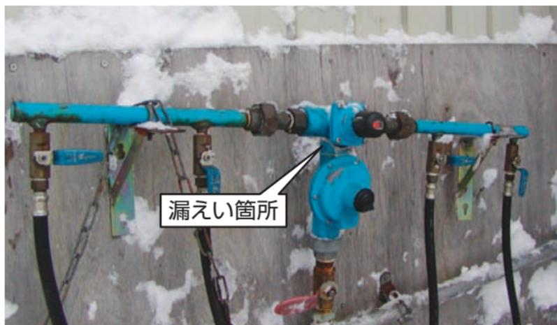
屋根から落下した氷塊で損傷した集合装置
